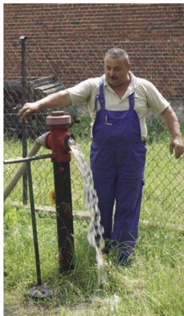
Rozruch nowego wodociągu w Księginicach przeprowadzony przez pracownika wodociągu „Bychowo”
