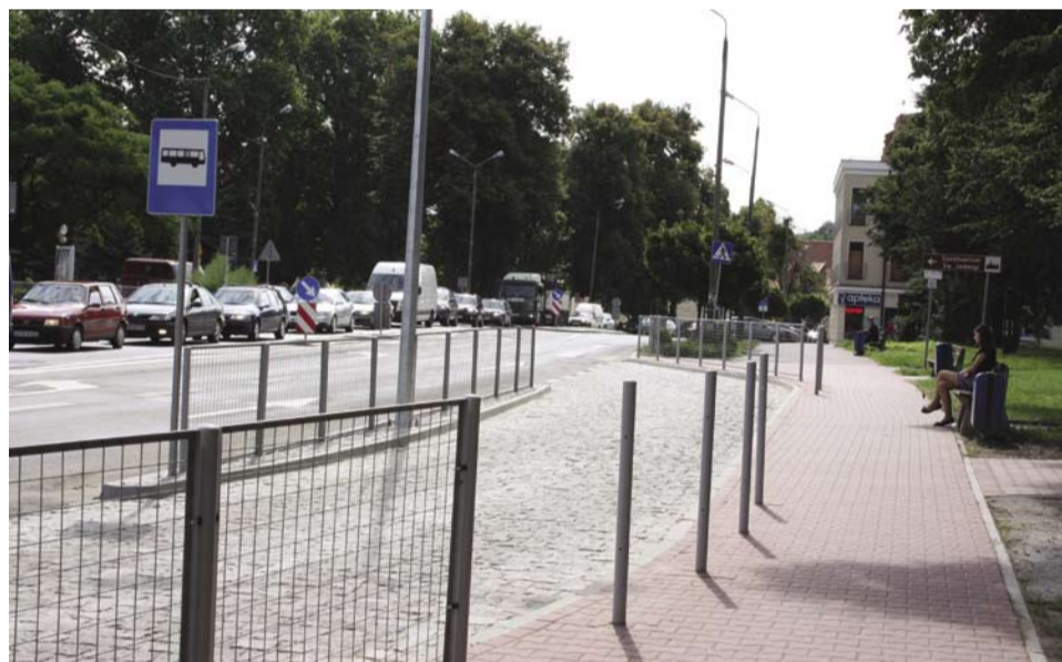
Na nowych zatoczkach autobusowych zatrzymują się autokary i busy pasażerskie. Zatoczki powstały w związku z przekształceniem placu M.J. Piłsudskiego na parkingi
