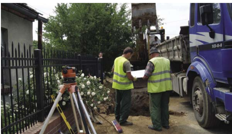
Prace mające na celu przyłączenie domostw Skarszyna do kanalizacji
