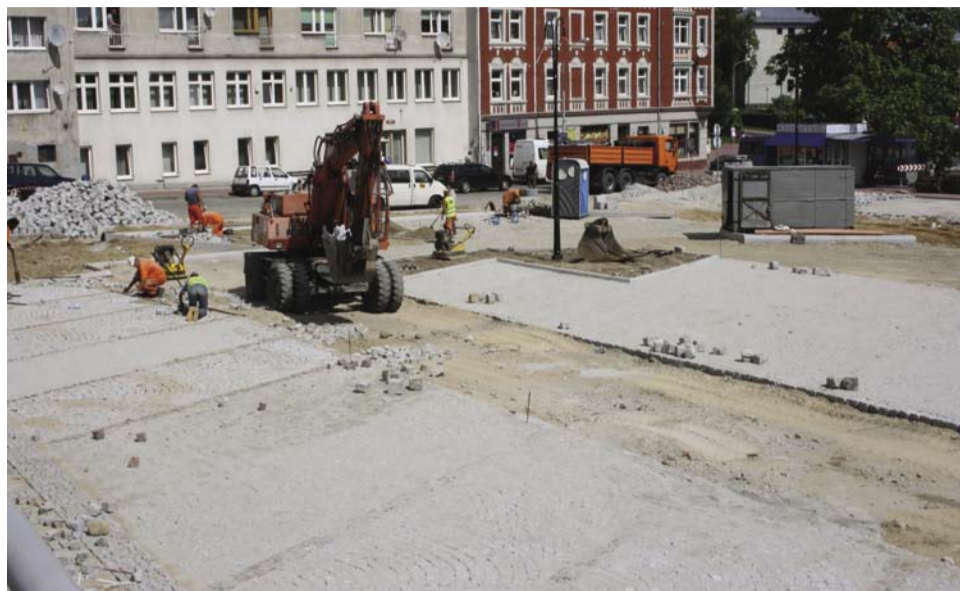
Po zakończeniu prac przed Urzędem Miejskim, na nowym parkingu w centralnym miejscu miasta powstanie 90 miejsc parkingowych
